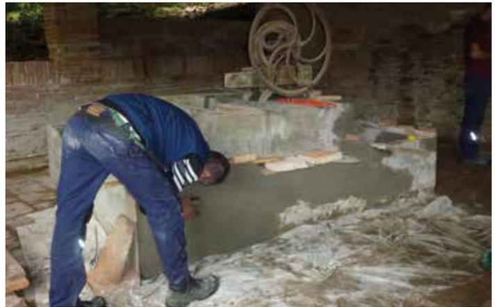
Des travaux ont été réalisés en juin 2015 sur le lavoir (rejointoiment des briques, rénovation du sol, nettoyage de la toiture).
