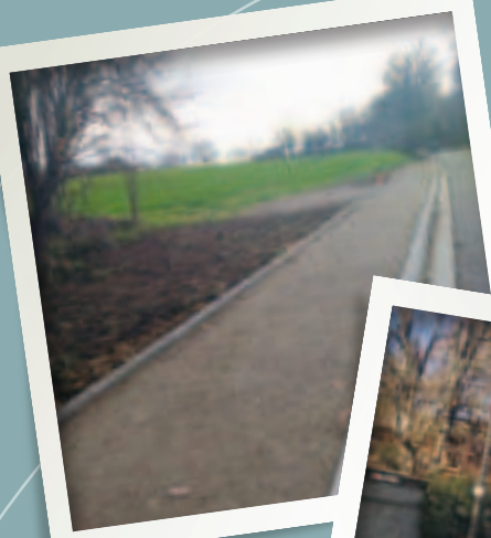
Travaux La Castellane
